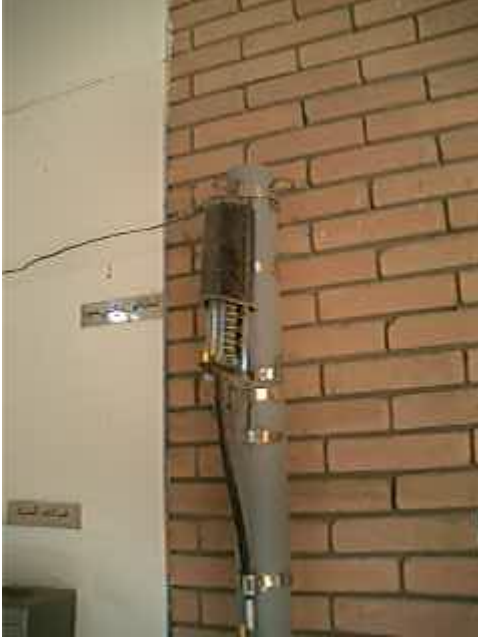
شكل ( ٥ ) يوضح أنواع وحدة صندوق التوزيع الموجود على مباني المشتركين
